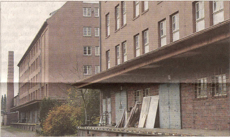
Wo einst die Standortverwaltung untergebracht war, könnte das „Speicherquartier Lüneburg“ entstehen. Foto: A/t & w
