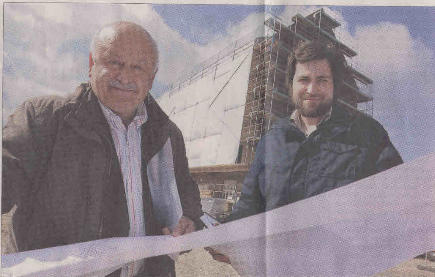
Das Speichergebäude ist eingerüstet. Was hinter dem Mauerwerk an komfortablen Wohnungen sowie Gewerbeflächen entstehen soll, erläutern Armando (l.) und Nico Esfandiary.
